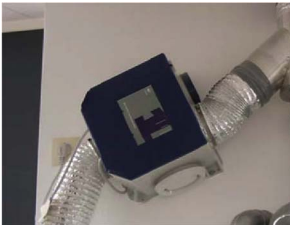
Afb. 12 Ventilatieunit voor enkel mechanische afzuiging
