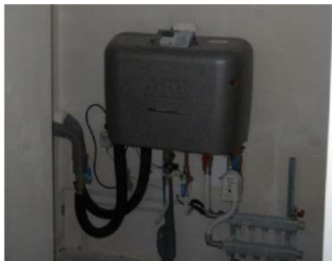
Afb. 10 a. Stadsverwarmingsunit (tevens tapwater) b. Secundaire stadsverwarmingsaansluiting (alleen CV)
