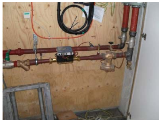
Afb. 10 a. Stadsverwarmingsunit (tevens tapwater) b. Secundaire stadsverwarmingsaansluiting (alleen CV)
