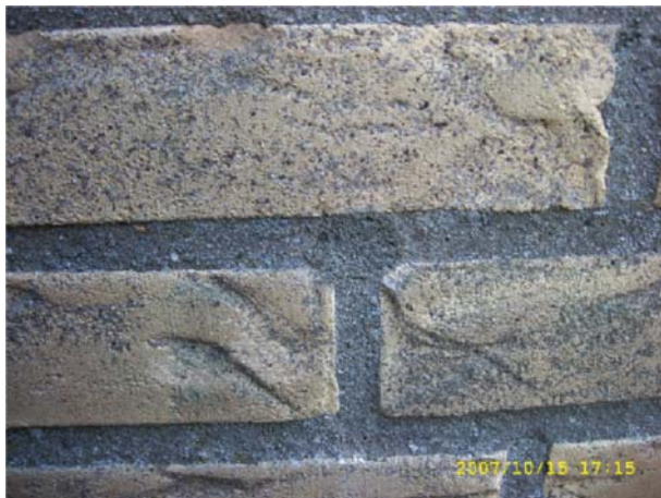
Afb. 3 Boorgat in de gevel
