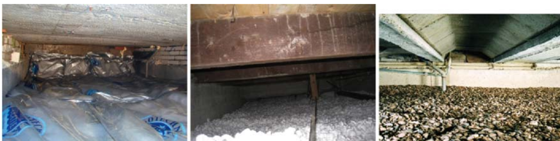
Afb. 7 Isolatie in de kruipruimte, met respectievelijk isolatiedekens, parels en schelpen
