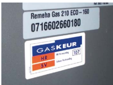
Afb. 8 CV-ketel met HR keur (HR107)
